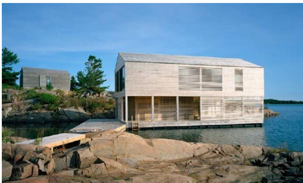
Figura 1 - Casa flutuante no Lago Huron, Michigan, EUA
