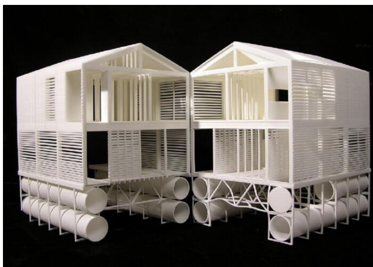
Figura 2 - Aspecto construtivo de uma casa flutuante
