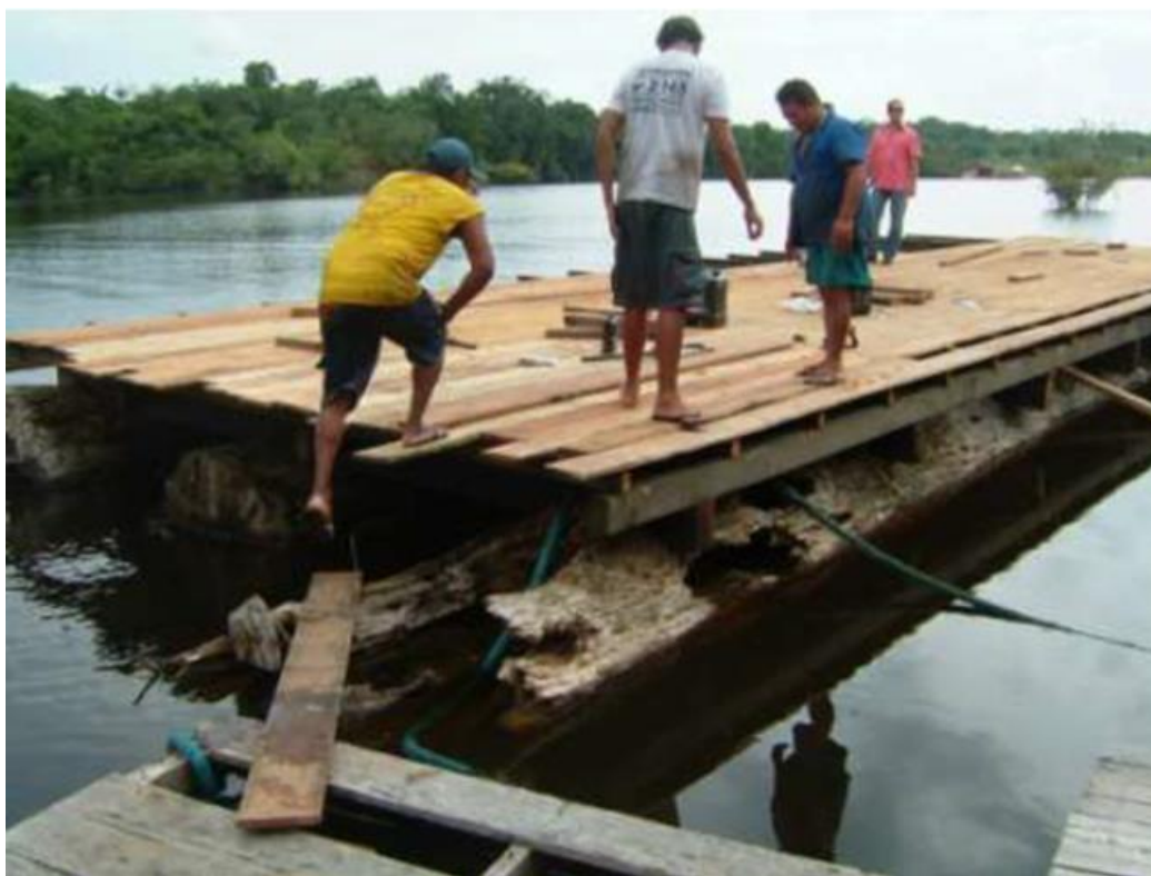
Figura 6 - Construção da estrutura de sustentação de uma casa flutuante
